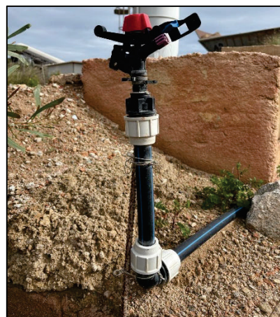
Foto 1: Sistema di abbattimento polveri e particolare idrante
